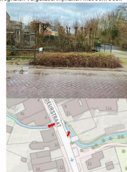
B Verbeteren oppervlakkige afstroming - weghalen vergetatie/vrijmaken instroom beek
