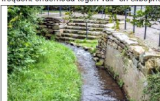
4 Verbeteren doorstroming beek - frequent onderhoud tegen vuil- en slibophoping
