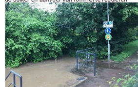
4 Buffer bovenstrooms van de beek - stroming door de duiker en aanvoer van rommel te reguleren
