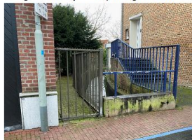
A Verbeteren oppervlakkige afstroming - weghalen muurtje + stoep verlagen/verkanten
