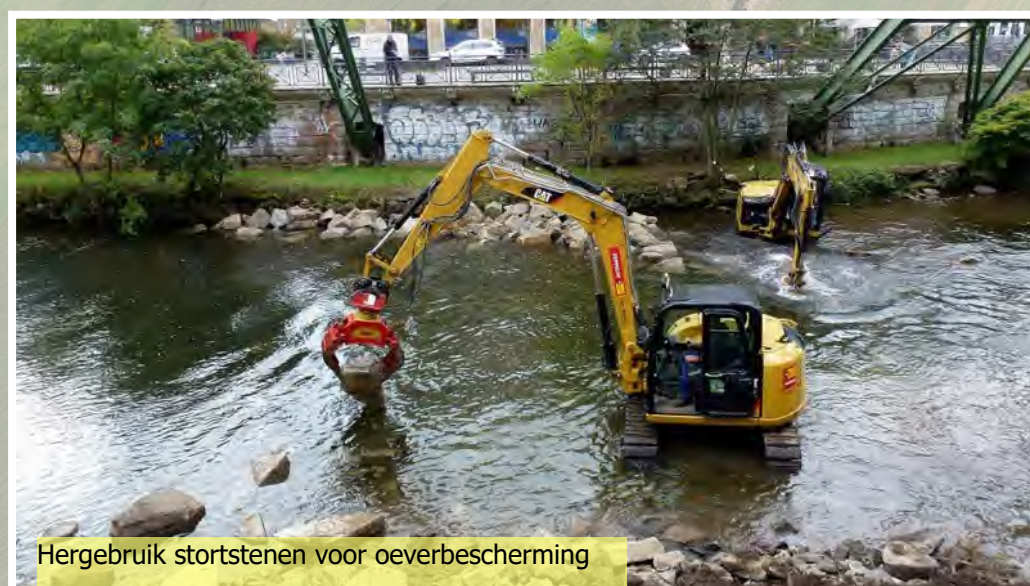
Hergebruik stortstenen voor oeverbescherming
