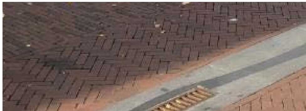
Hardstenen goot in de Haspelsestraat
