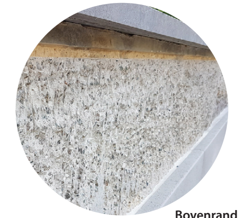
Bovenrand: strak beton, iets uitstekend
