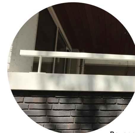
Bovenrand: strak beton, stalen koker
