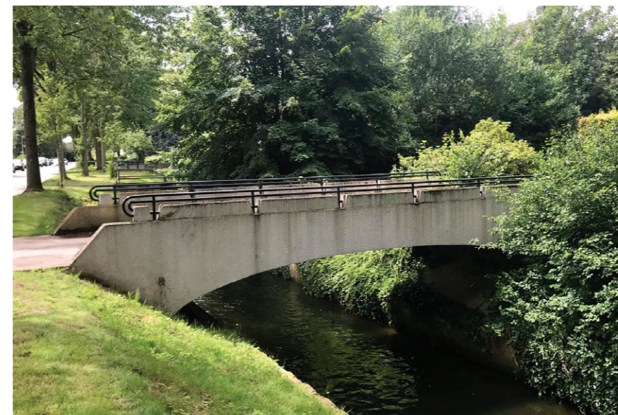
Foto van de huidige brug
