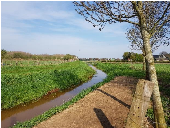
Zicht op de brug over de Kwistbeek vanaf het plangebied
